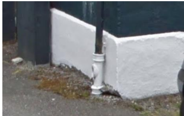
Figur 23 - Eksempel på takvann ned i grunn (Google Streetview)
