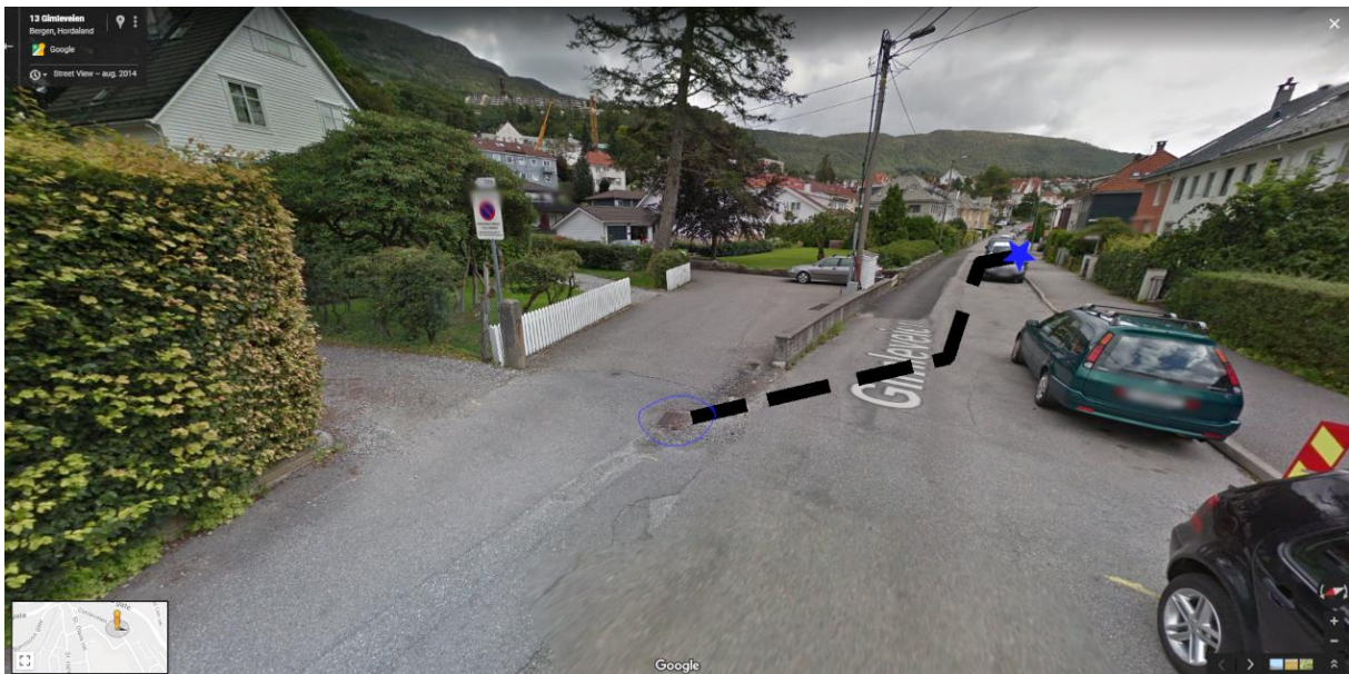
Figur 28 - Gammel kum og eksisterende overvannsledning (Google Streetview)
