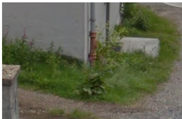
Figur 22 - Eksempel på takvann ned i grunn (Google Streetview)
