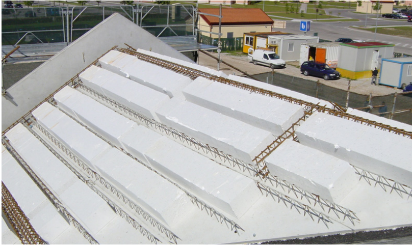
Figur 6.6: Isopor mellom gitterdragere. [45]
