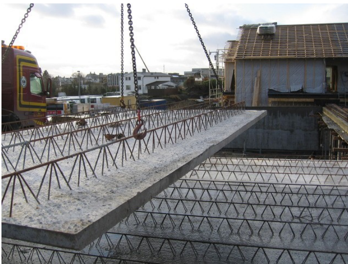
Figur 6.3: Montering av plattendekke. [43]
