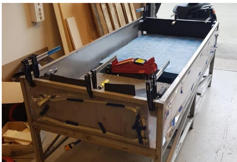
Figur 2-16: Sideplatene limes fast i rammen. Trykk påføres slik at platene ikke beveger seg.
