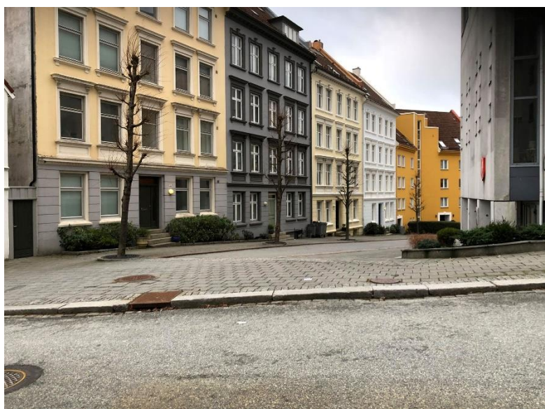
Figur 46: "medium rise blocks" i Repslagergaten. Foto: Eivind Iden Berge.
