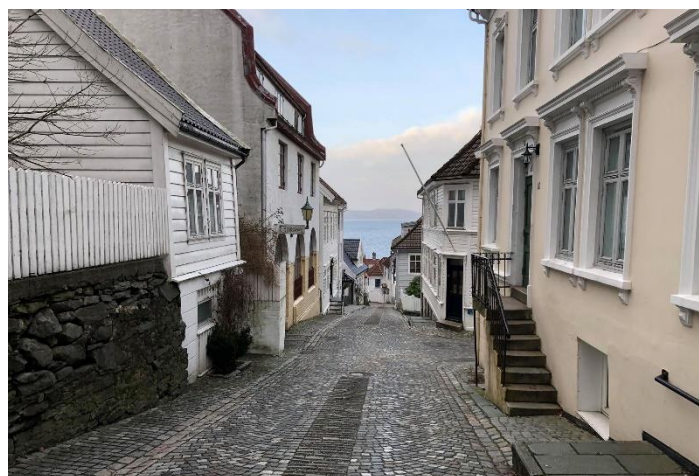
Figur 61: vindus- og inngangspartier ligger tett i tett langs Skuteviksveien. Foto: Eivind Iden Berge.
