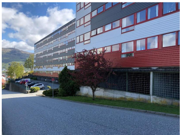
Figur 63: første etasje fungerer som parkeringsgarasje i blokkene langs Frydenbølien. Gaten er derfor vurdert som "un-constituted". Foto: Eivind Iden Berge.
