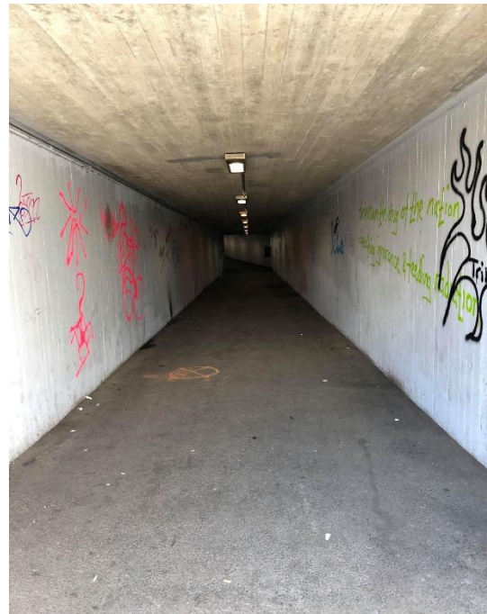
Figur 94: "hærverk", «god skjerming» og tilstedeværelse av folk tilknyttet Strax-huset, gjør at folk generelt holder seg unna tunnelen. Foto: Eivind Iden Berge.
