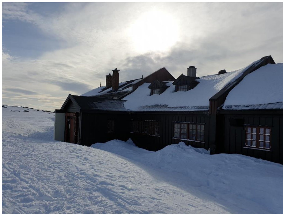
Bilde 3 Nordsiden av Sandhaug
