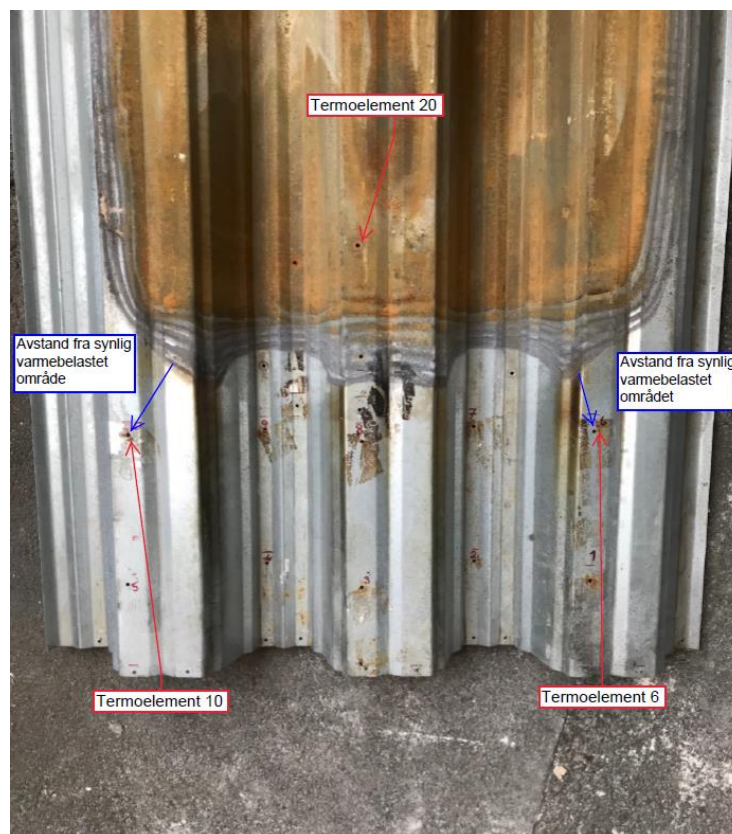
Figur 30 - Varmebelastet stålplatetak med avstand fra termoelement 6 og 10 til varmebelastet område
