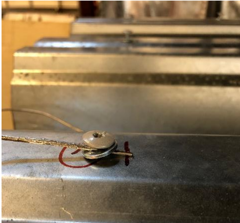
Figur 23 - Festing av termoelementer i stålplattetak
