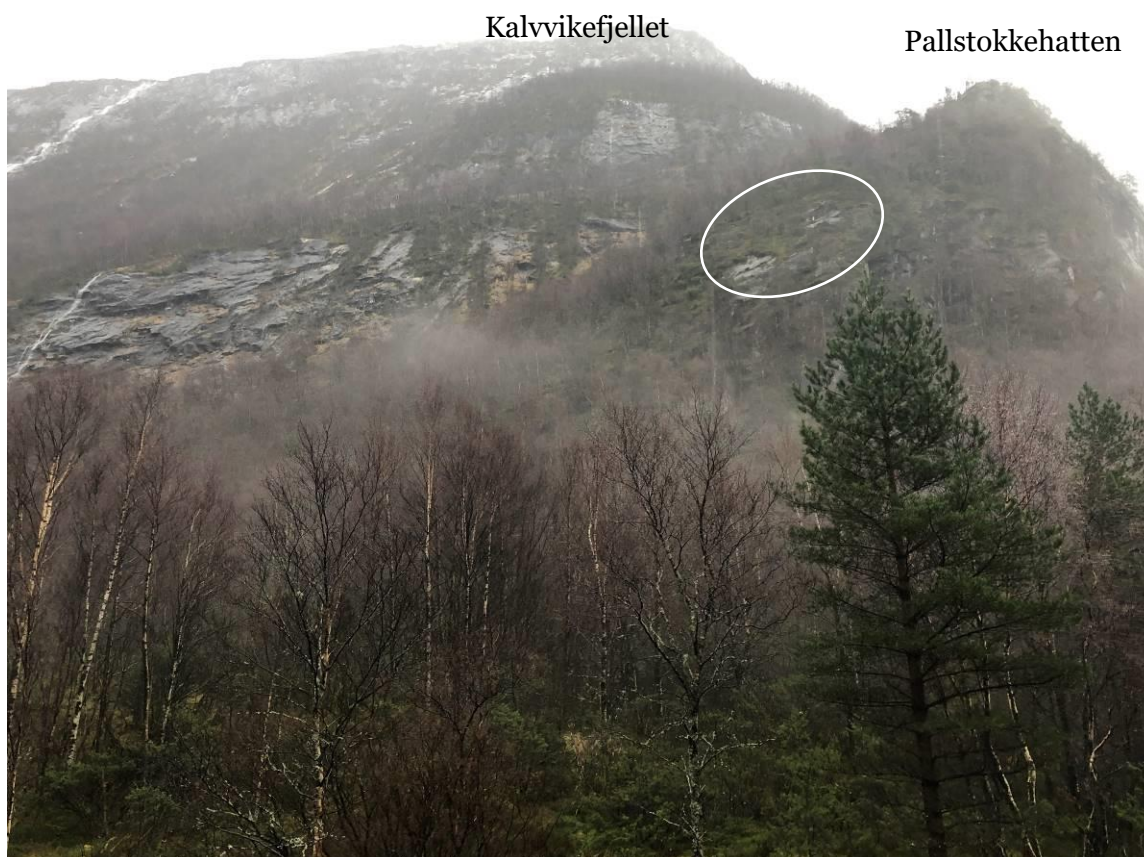
Figur 13: Bratt fjellskrent i nordre enden av Pallstokkehatten over tomt 57/27 merket med hvit ring, tilsvarende parti er også markert i Figur 17. Steinsprang fra Kalvikefjellet når ikke over ryggen
