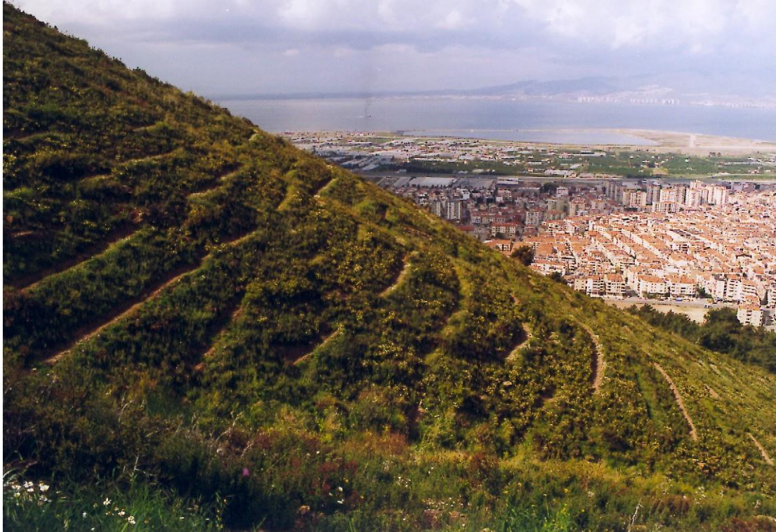
Fig. 5: Terrasser for å hindre erosjon i en åsside
