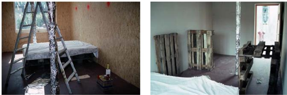
Figur 15. Rom med OSB kledning til vestre og gipskledning til høyre
