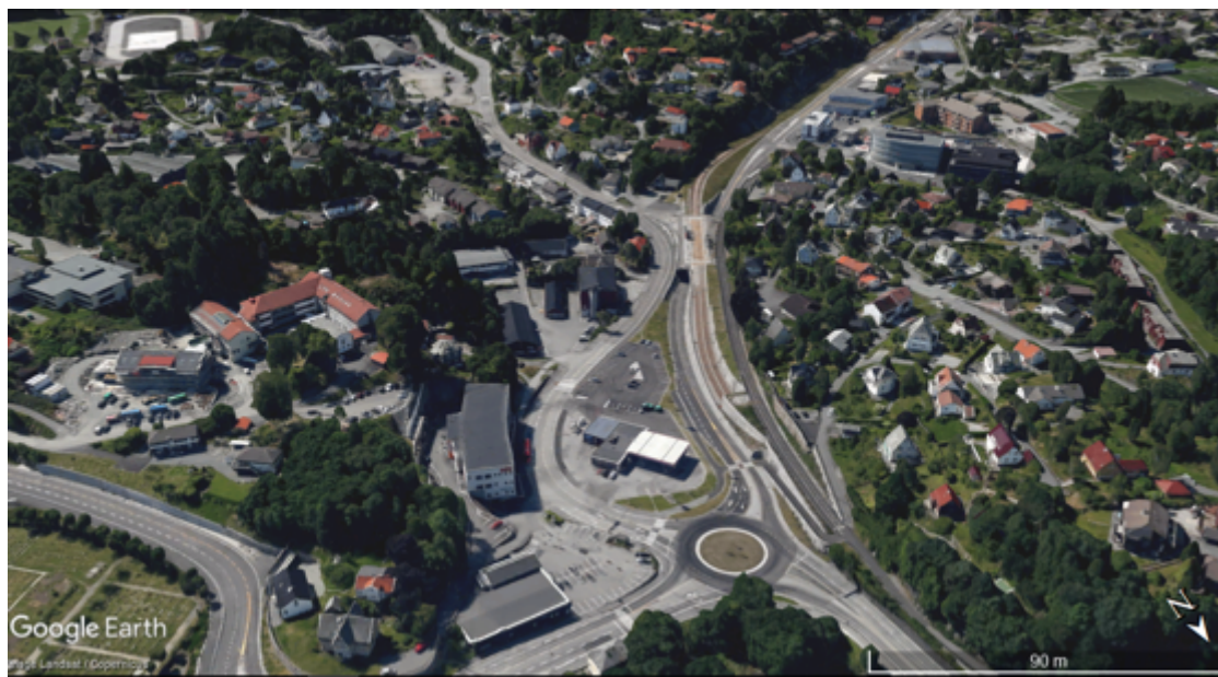
Figur 14: Oversikt over Skjold, sett fra nord. (Hentet fra www.googleearth.com )
