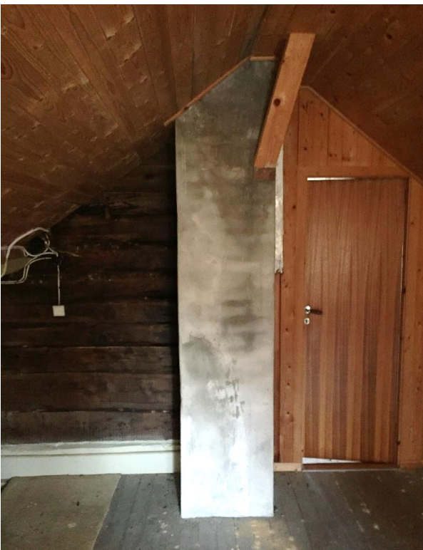
Bilde 5 Pipe utført i halv teglstein mot brennbar konstruksjon
