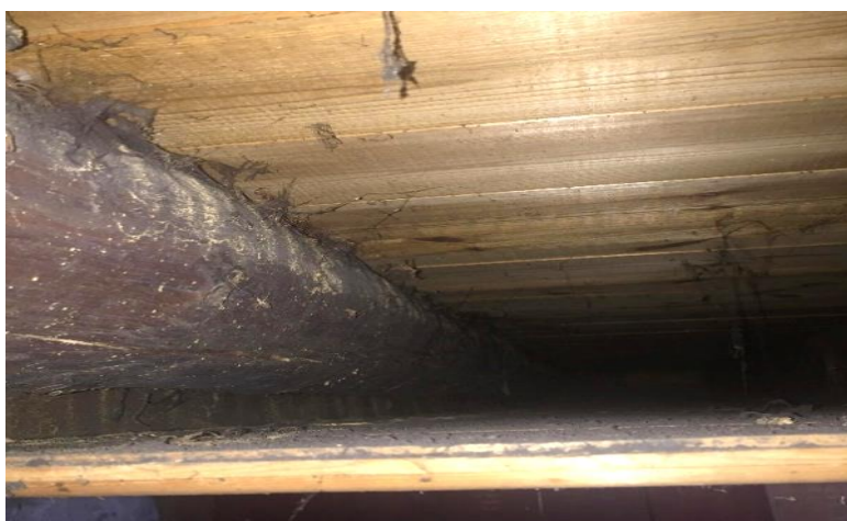
Bilde av etasjeskiller mellom 1. og 2. etasje.
