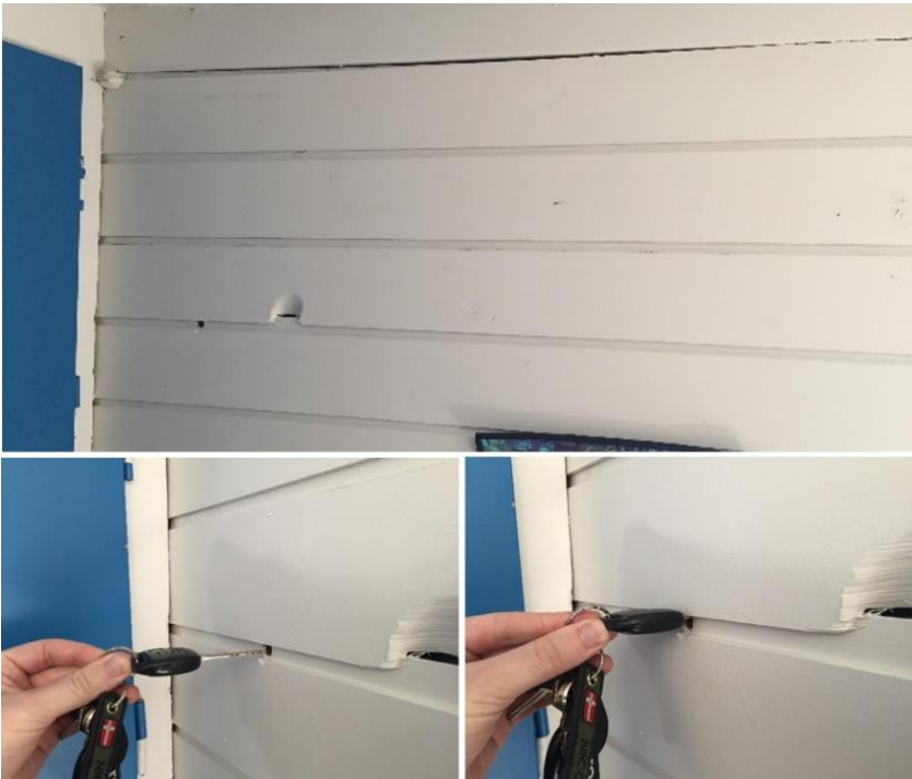
Bilde 2 Innvendig panel påført ved utlekting på tømmerkasse
