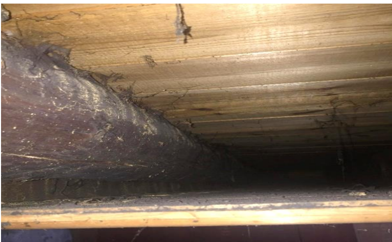
Bilde 1 Bjelkelag utført med golvbord og himlingspanel
