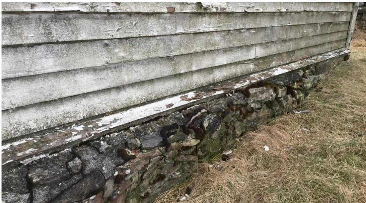
Bilde av utvendig kledning som flukter med grunnmur.
