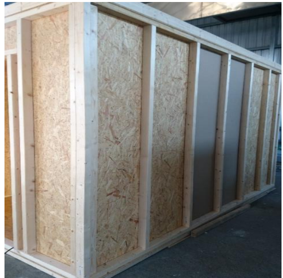
Bilde 6 Utside av langvegg med gipsplate i midten
