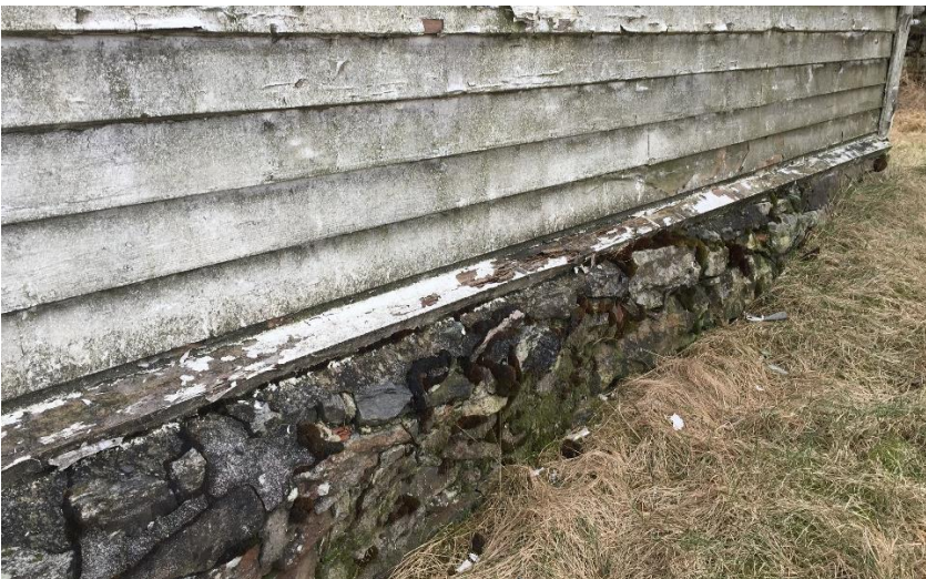
Bilde 3 Ytterkledning på tømmerkasse plassert direkte på grunnmur
