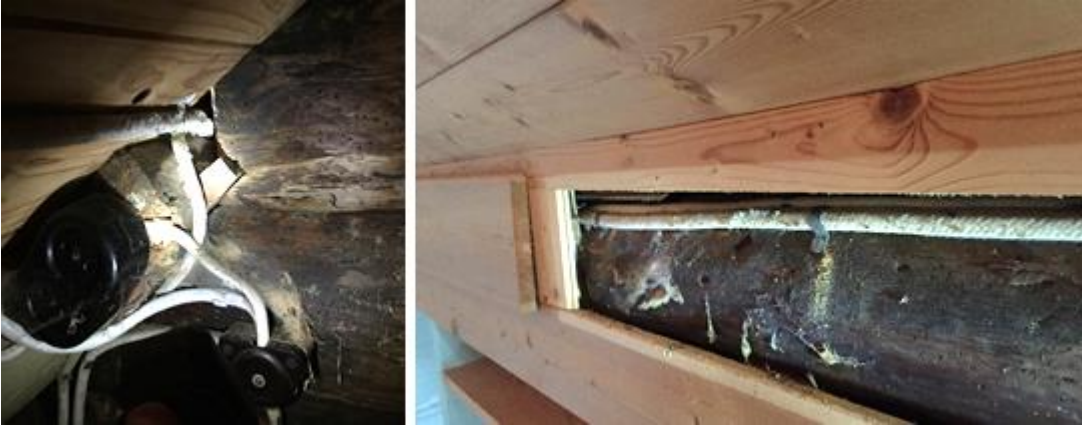
Bilde 4 Gjennomføring av elektriske installasjoner i vegg. På den annen side av veggen er ledningen trukket i lukket hulrom under kledning
