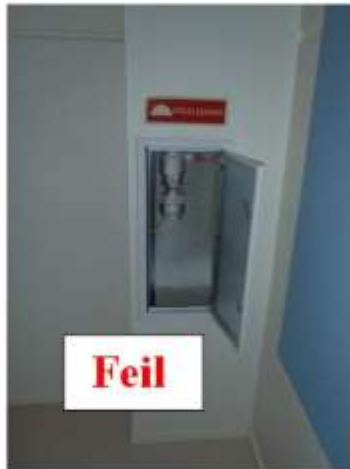
Figur 8 Koblinger må være innrettet slik at slanger kan kobles på uten å komme i konflikt med bygningskonstruksjoner eller lignende Rundt Ø 65 mm NOR Lås I koblinger må det være god plass for å kunne bruke koblingsnøkler
