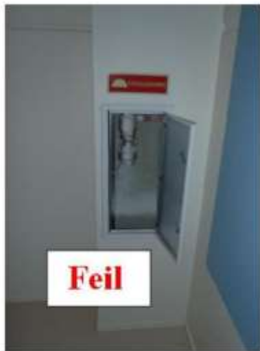
Figur 6: Viser hvordan tilkoblingspunktet ikke skal settes opp. Det er viktig at det er god plass rundt tilkoblingspunktet, slik at det ikke skapes konflikt med bygningsdelene ved tilkobling.
