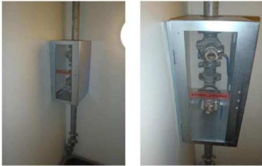
Figur 7: Viser en god mglichet p hvordan en ventil kan beskyttes.
