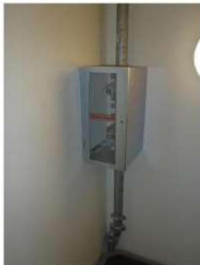
Figur 9 Godt eksempel på skap for beskyttelse av stigeledning/tørroplegg mot hærverk.
