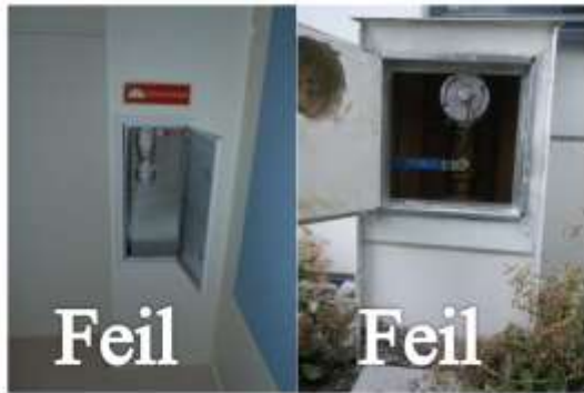
Figur 5 Koblinger må være innrettet slik at slanger kan kobles på uten å komme i konflikt med bygningskonstruksjoner eller lignende Rundt Ø 65 mm NOR Lås 1 koblinger må det være god plass for å kunne bruke koblingsnøkler
