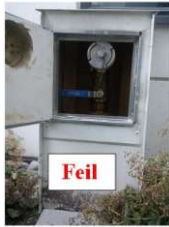
Figur 8 Koblinger må være innrettet slik at slanger kan kobles på uten å komme i konflikt med bygningskonstruksjoner eller lignende Rundt Ø 65 mm NOR Lås I koblinger må det være god plass for å kunne bruke koblingsnøkler
