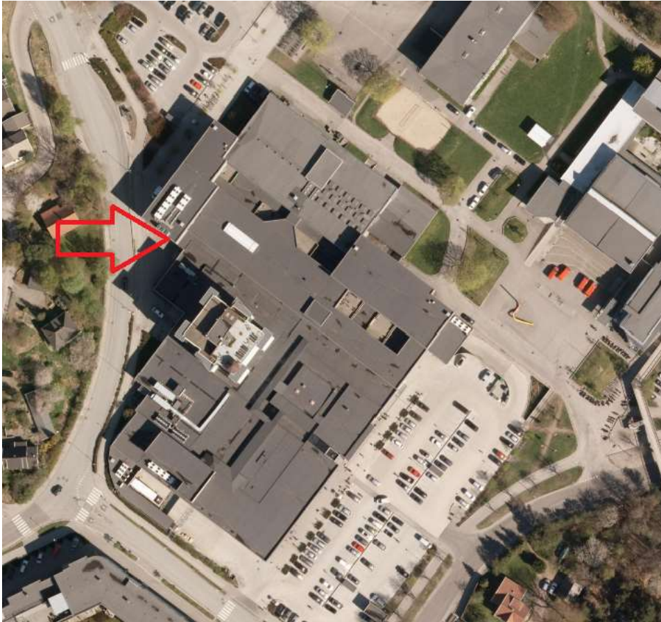
Figur 9: Illustrer bygget etter påbygging, hvor det vil være vanskelig for rednings- og slokkemannskap å nå frem til alle deler av bygget.
