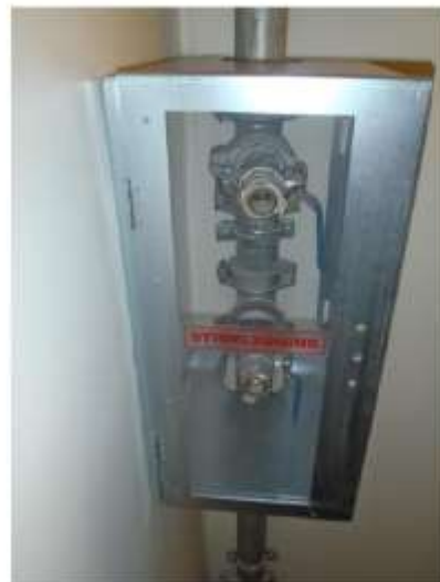
Figur 9 Godt eksempel på skap for beskyttelse av stigeledning/tørroplegg mot hærverk.
