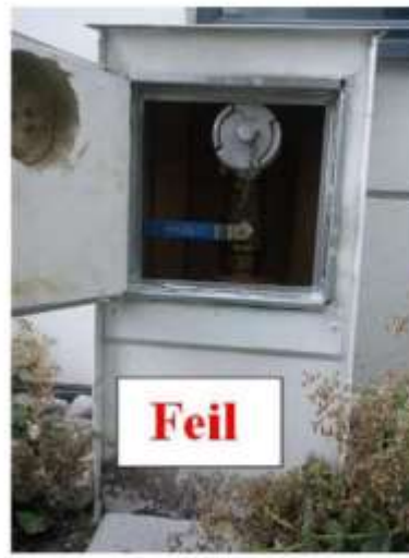
Figur 6: Viser hvordan tilkoblingspunktet ikke skal settes opp. Det er viktig at det er god plass rundt tilkoblingspunktet, slik at det ikke skapes konflikt med bygningsdelene ved tilkobling.
