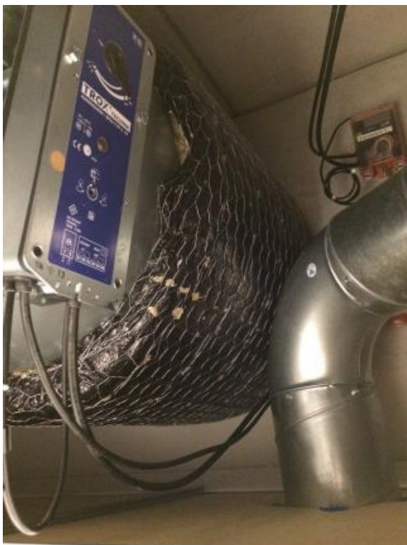
Bilde 9 og 10: Utført montasje av brannspjeld på utsiden av vegg og riktig montasje av brannspjeld i vegg
