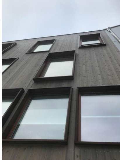
Bilde 8: Rehabiliterert fasade med ny kledning.
