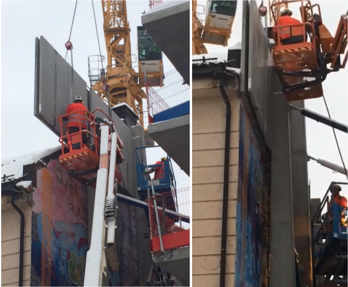
Bilde 1: Viser pågående monteringsarbeid av en brannvegg
