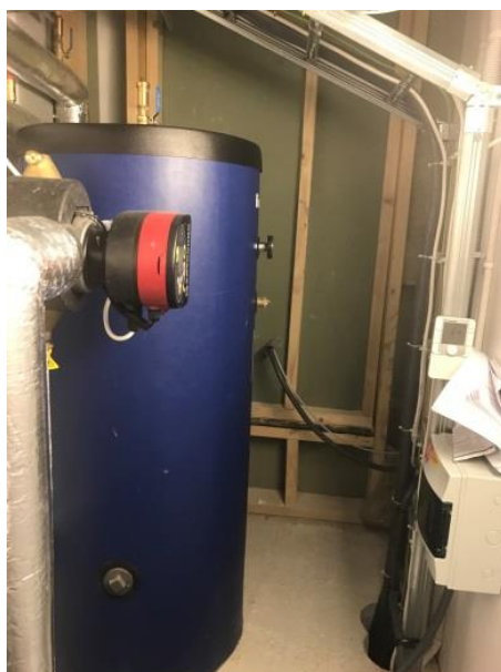
Bilde 6: Vegg mellom teknisk rom og trapperom/rømningsvei er kun utført med ett lag 13 mm gips og trestenderverk uten tilstrekkelig dokumenterbar brannmotstand EI 60 A2-s1,d0 [A 60].
