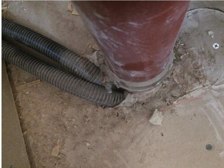
Bilde 4: Bilde av benyttet Nullifire FF 197 i dekkekonstruksjon med trebjelkelag
