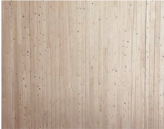
Figur 5: Fra Nardo skole, gliper mellom elementer
