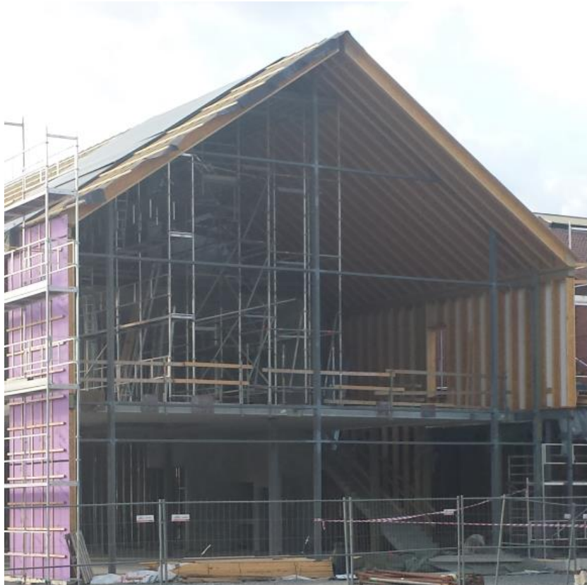
Figur 2 Samvirkekonstruksjon av stål og betong, med utfyllende bindingsverk av tre
