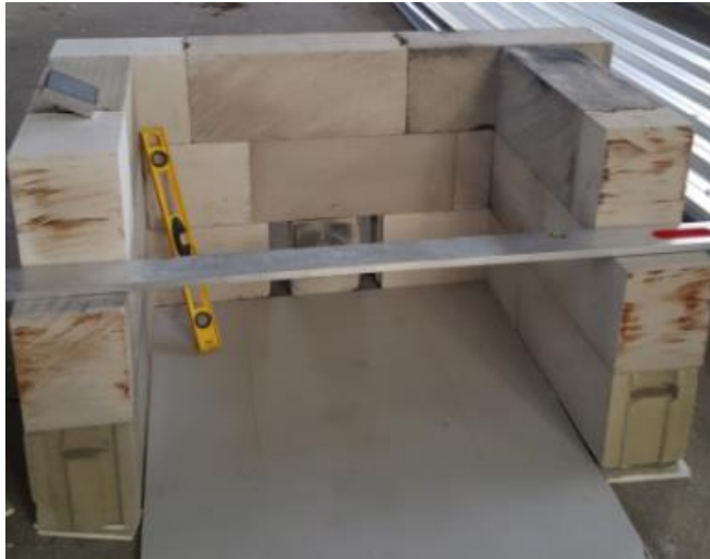
Figur 19 Brennkammer under oppføring
