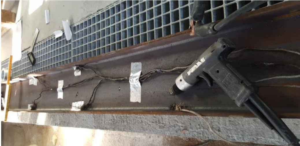
Figur 30 Punktsveising av termoelement i stålbjelke
