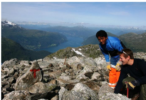
Figur 7.3. Sherpaer og lokal dugnadsinnsats i arbeid med steinsetting av stien over Skaret (Anne Rudsengen, 2009).
