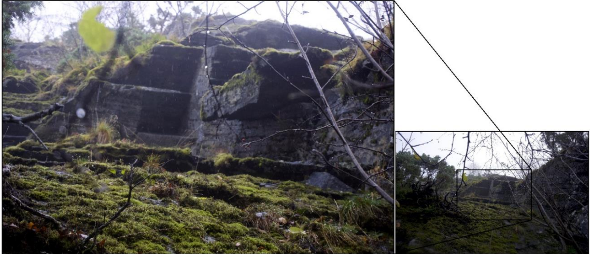
Figur 24: Sprekkesettene gir opphav til rektangulære blokker. Foto: Thomas Danielsen.
