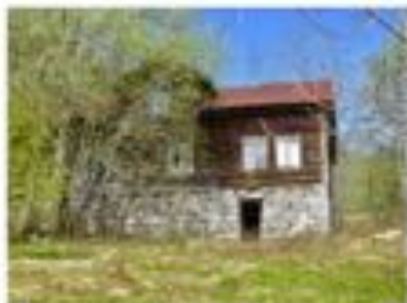
Bolig i forfall på Engjasete, bruk 3/1
