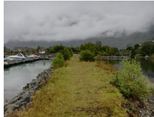
Figur 31 - Fotoet viser gjengroing på moloen. Her ser man at problemet blir mer omfattende nærmere land.
