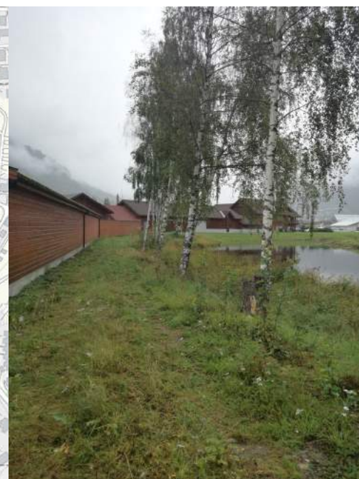
Figur 39 - Foto fra befaring viser siste del av turveien som ikke er ferdig utbygd. Til høyre kan man skimte sentrum på andre siden av riksvegen.
