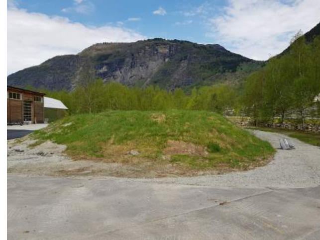
14– Pumpehus. Pumpehuset er begravet under en gressvoll og ligger til venstre for den nye regulerte turveien.
