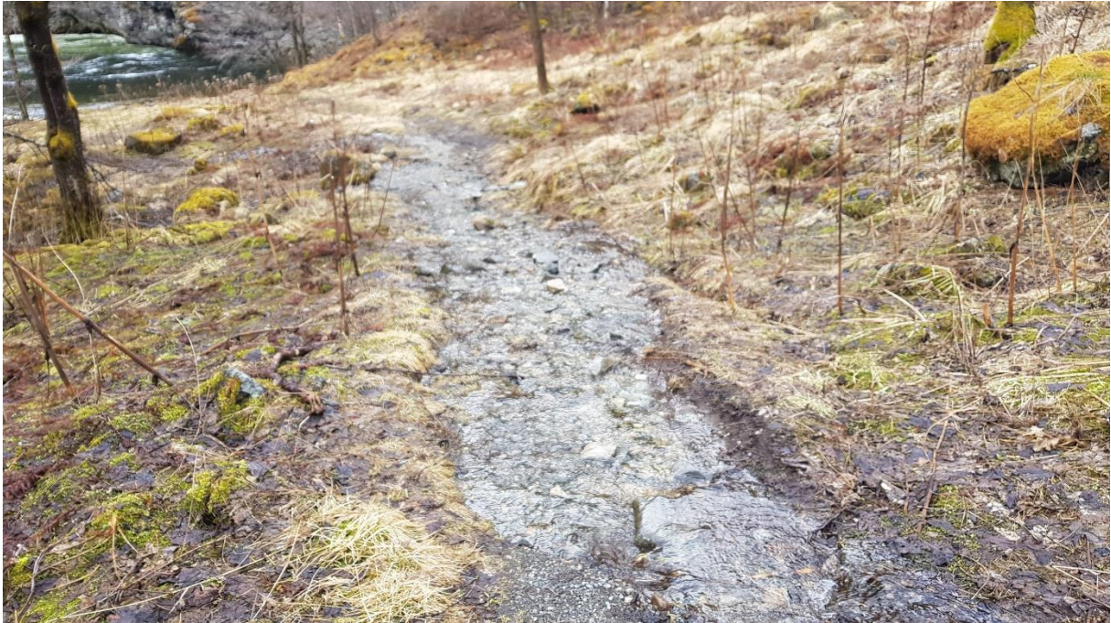
Figur 65. Dagens sti ned til den åpne plassen ved Uvla. Den er gjørmete og i nokså dårlig stand, og fungerer i praksis som en bekk. En enkel utbedring av denne kan sikre lettere tilgjengelighet med for eksempel barnevogn eller sykkel.
