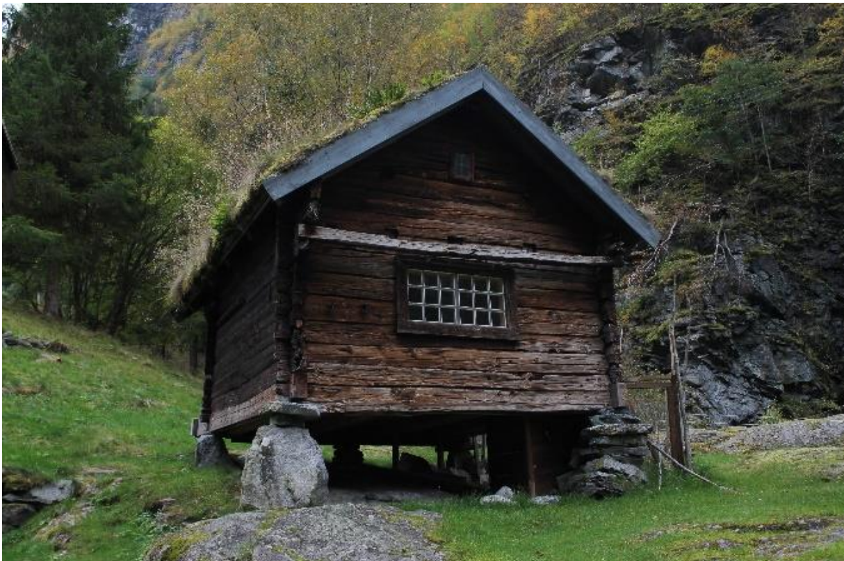
Figur 26. Fotografiet viser en tradisjonell bygning på Skåri. Her ser man en tydelig representasjon av planområdets byggeskikk, med laftet stil og gresstak.
