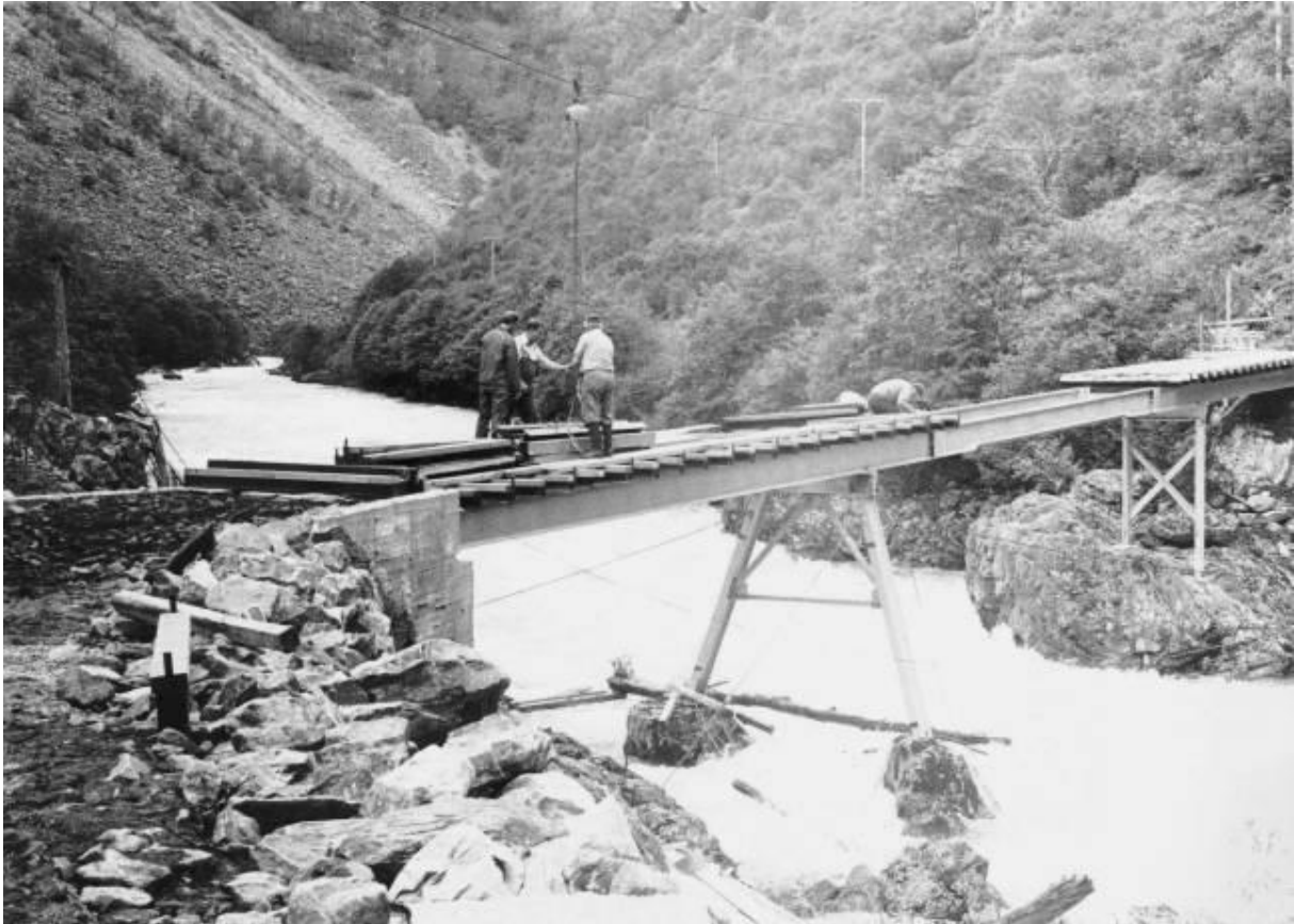
Figur 22. Fotografiet er tatt under byggingen av Folkevegen. Her ser man konstruksjonen av Hedleribrui, en av Folkevegens fire broer. Foto: Jan B. Paulsen (ukjent dato).
