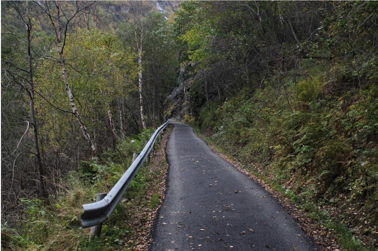
Figur 31. Fotografiet viser partiet med asfalt som begynner rundt 1 kilometer fra Vetti. Folkevegen har her også rekkverk grunnet det svært bratte terrenget ned mot Utiå.
