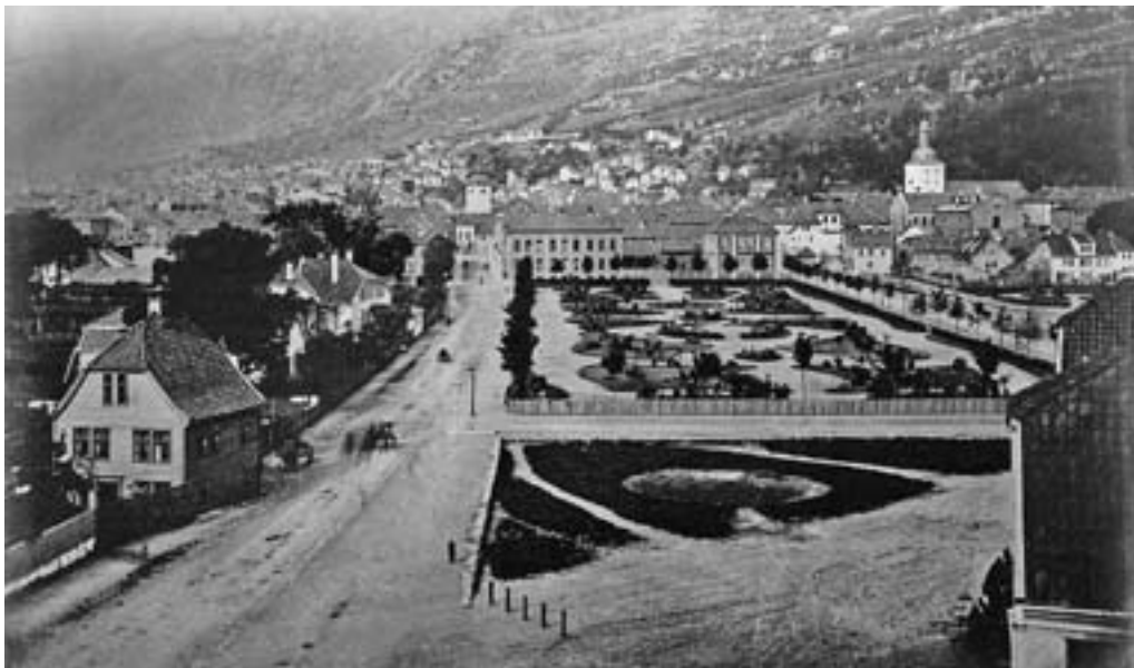
«Storebrannen» i 1855 førte til en omfattende regulering av Bergen sentrum. Gjennom brannstrøket og på utfylling i Lille Lungegårdsvann ble det regulert to nye gater, Olav Kyrres gate (t.v.) og Christies gate (t.h.). Mellom disse gatene ble Byparken opparbeidet og beplantet.
