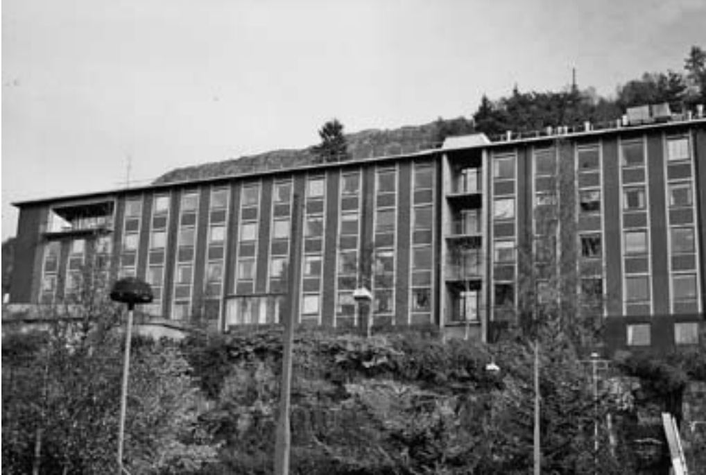
Armauer Hansens hus.
