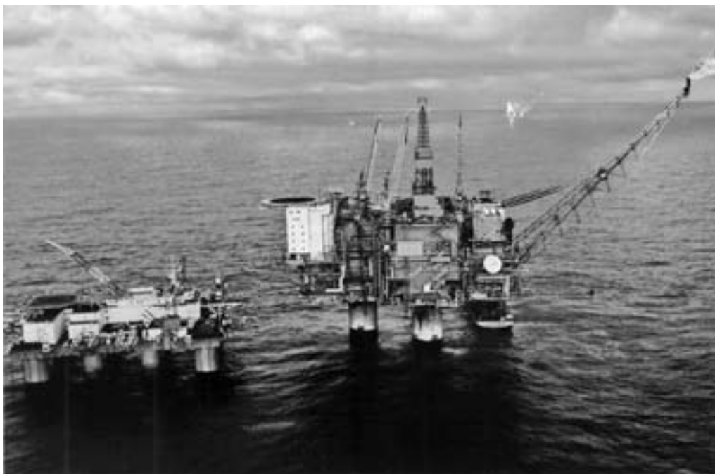
Statfjord A med flotellet Polycrown. Oljebransjen har skapt en rekke muligheter for ingeniørene.
