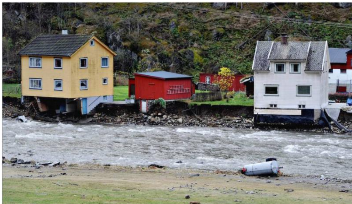
Figur 5: Bildet illustrerer noen av ødeleggelsene under hundreårsflommen i 2014 i Flåmsdalen ( http 13 ).
