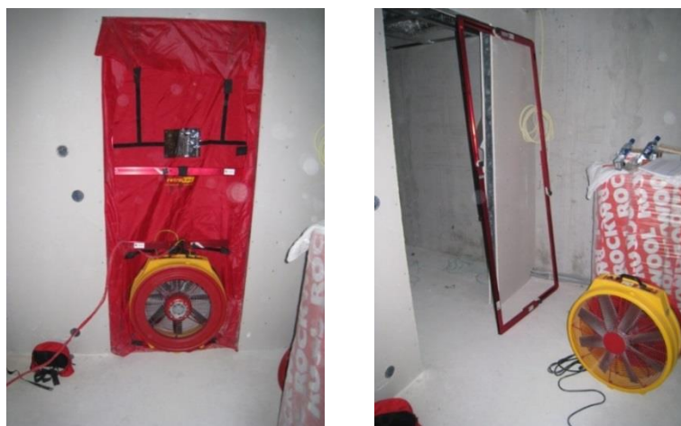
FIGUR 3:2 MONTERING AV BLOWER DOOR
