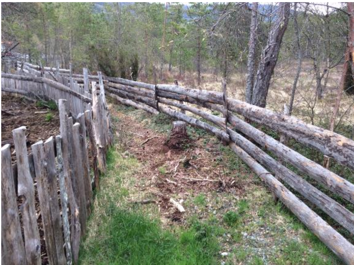
Figur 42: Fegata på museet er satt opp med stående hungard på én side og liggende hun på den andre.
