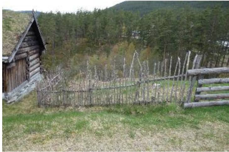
Figur 48: Her ser man to høyder med troer på baksiden av gjerdet. Lengden på stikkene varierer.
