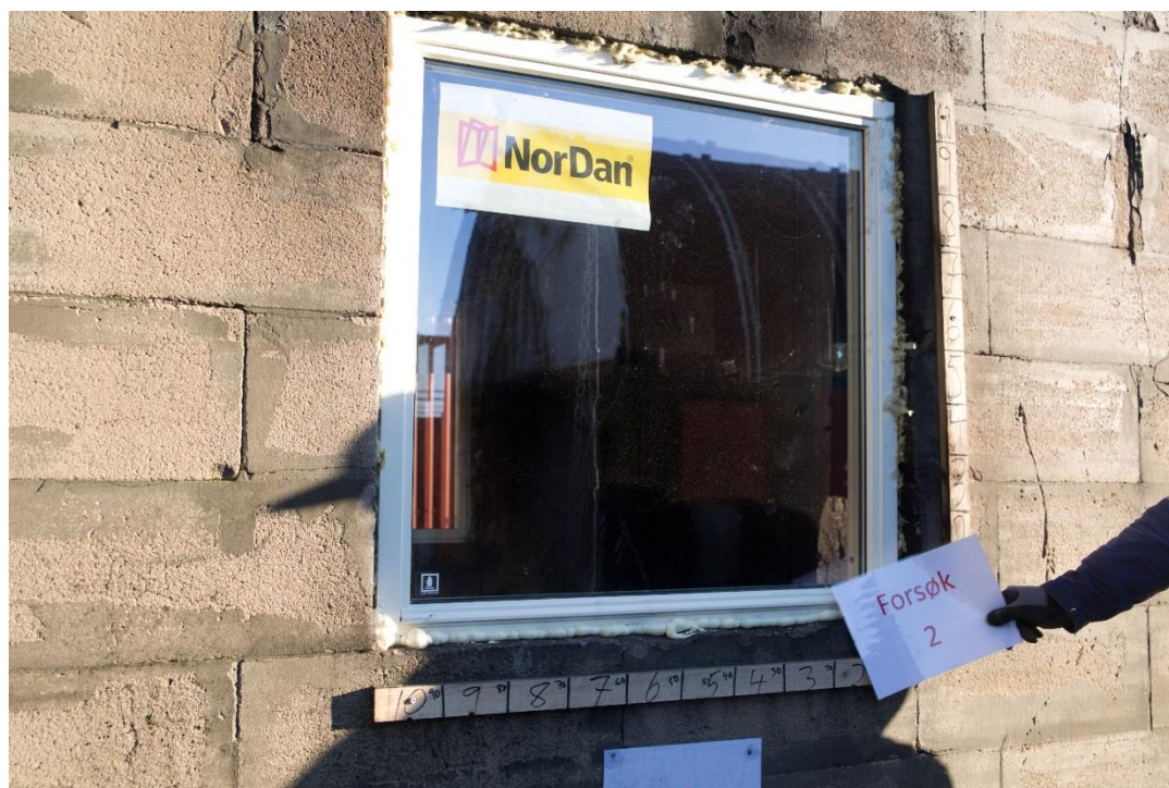
Bilde 1: Eksempel på ferdig montert vindu (Forsøk 2)
