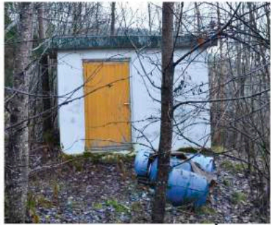
Pumpehus ved tursti
