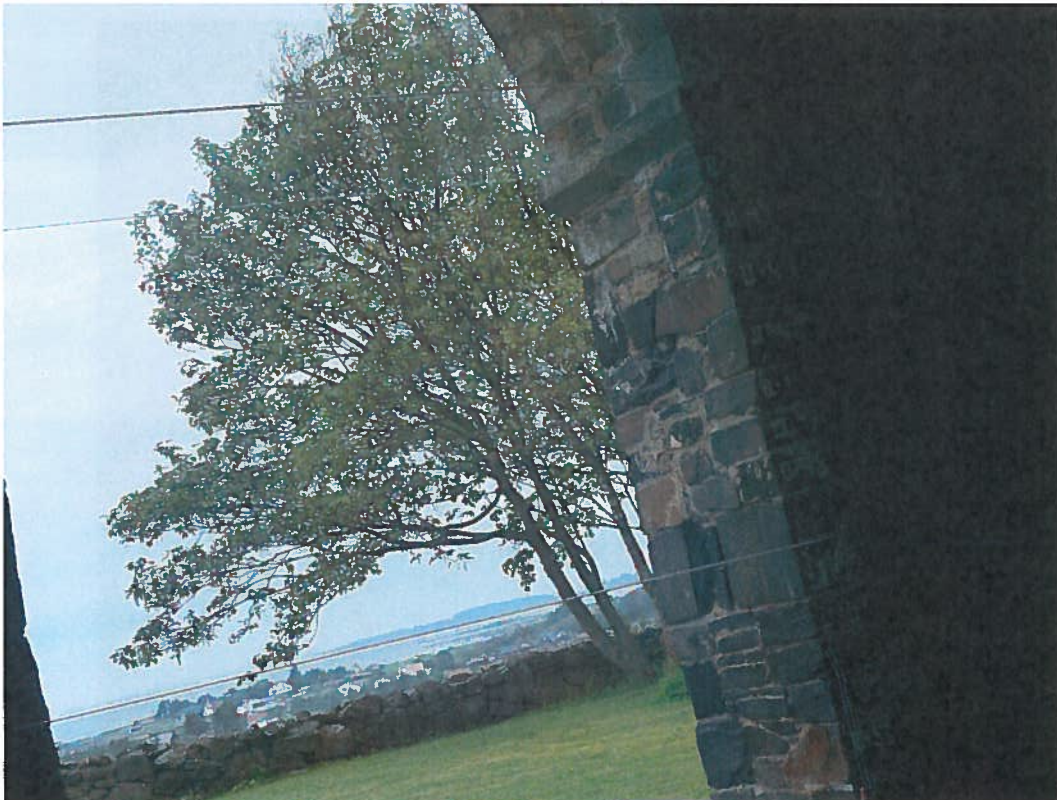
Figur 2. Sola ruinkirke med utsikt til havet (foto: eget).
