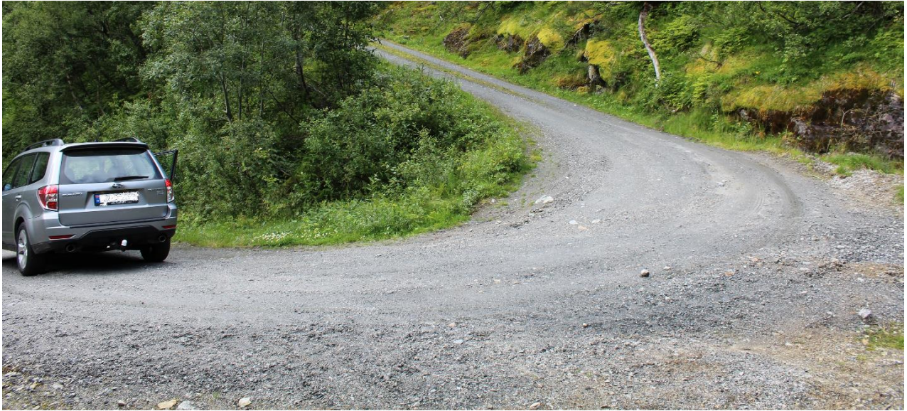
Figur 17. Her vises en av de mange svingene på vei opp til parkeringsplassen i Haugadalen. Veien er stedvis bratt og svingete, og egner seg ikke for større kjøretøy som buss og lastebil.
