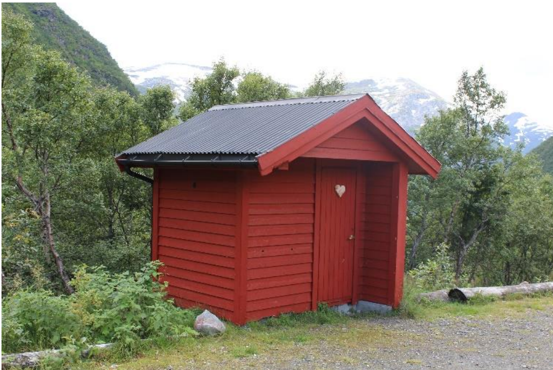
Figur 20. Toaletbygget som står på parkeringsplassen i dag.
