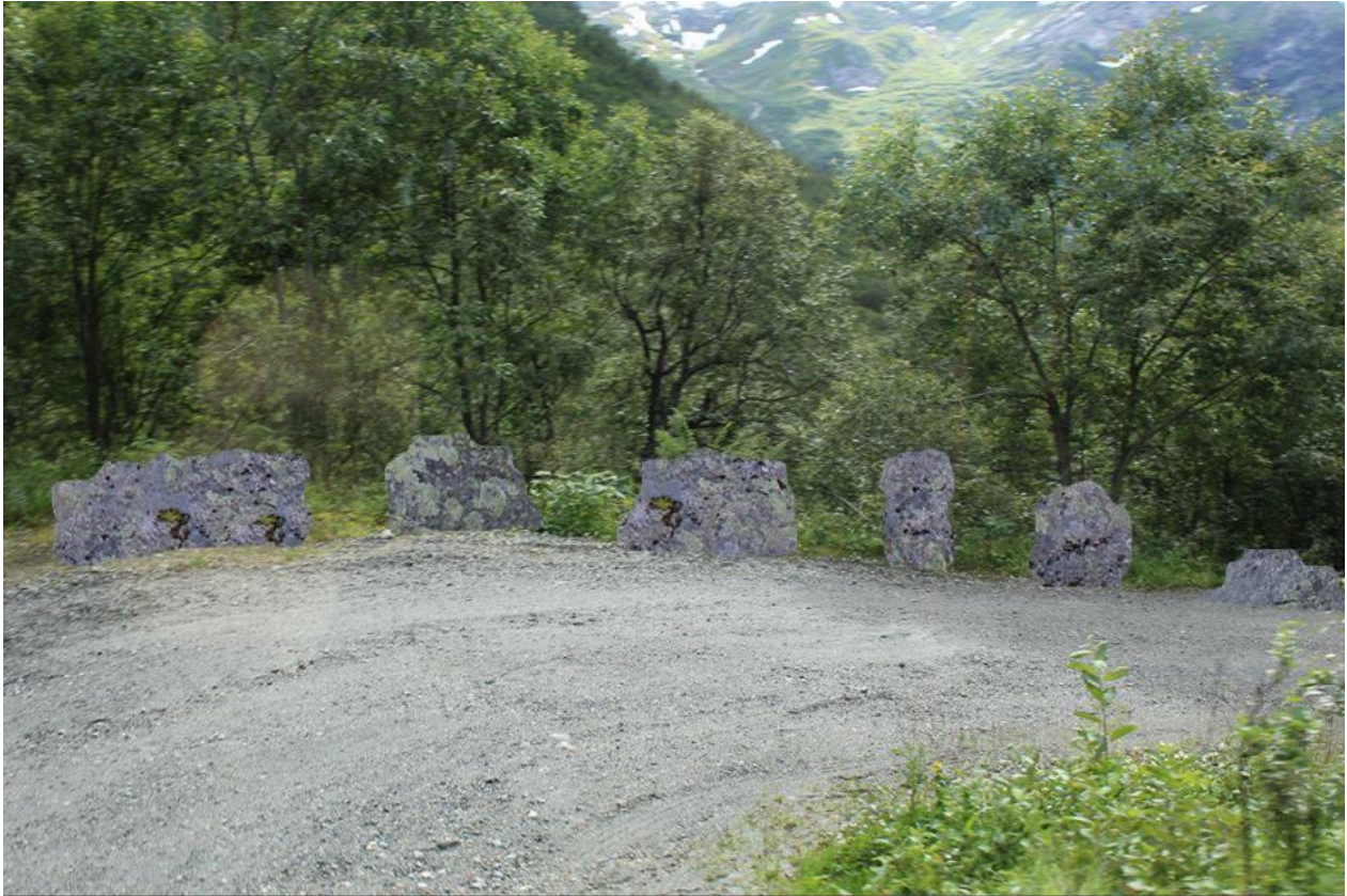
Figur 32. Planlagt veisikring i stein. Sikringen vil gi en tryggere opplevelse og samtidig gi et kulturhistorisk preg.
