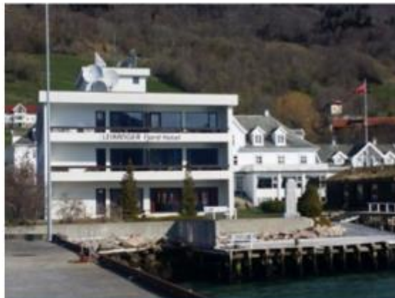
14 Leikanger Fjord Hotell - Leikanger Fjord Hotell har en ny og en eldre del. Hotellets nyeste del er et rendyrket eksempel på etterkrigsfunksjonalismen.
