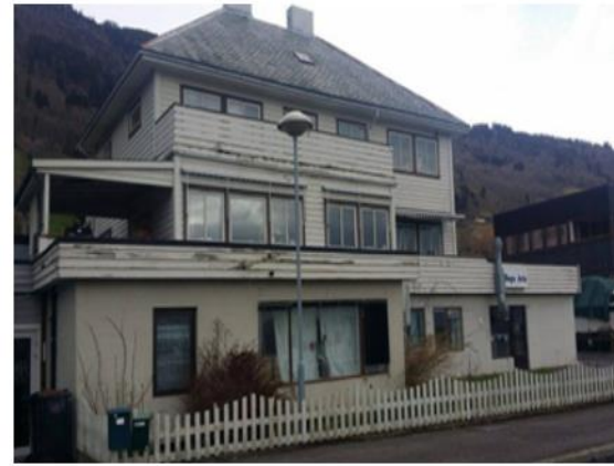
4 Næringsbygg/ leiligheter - Dette bygget tilhørte også Sogn Avis. Avisa hadde lokaler i første etasje, mens andre etasje ble brukt som bolig. Bygget er svært slitt og står i dag tomt. Bygget skal rives og bygges om til leiligheter.
