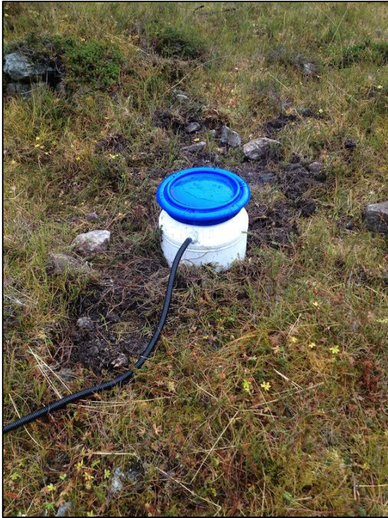
Figur 7 Bildet viser hvordan sensorene er gravd delvis ned i bakken og beskyttet av en plastikkbøtte. Ledningen som kommer ut av bøtta fører til kontrollhuset. Foto: Ørjan Sørderblom
