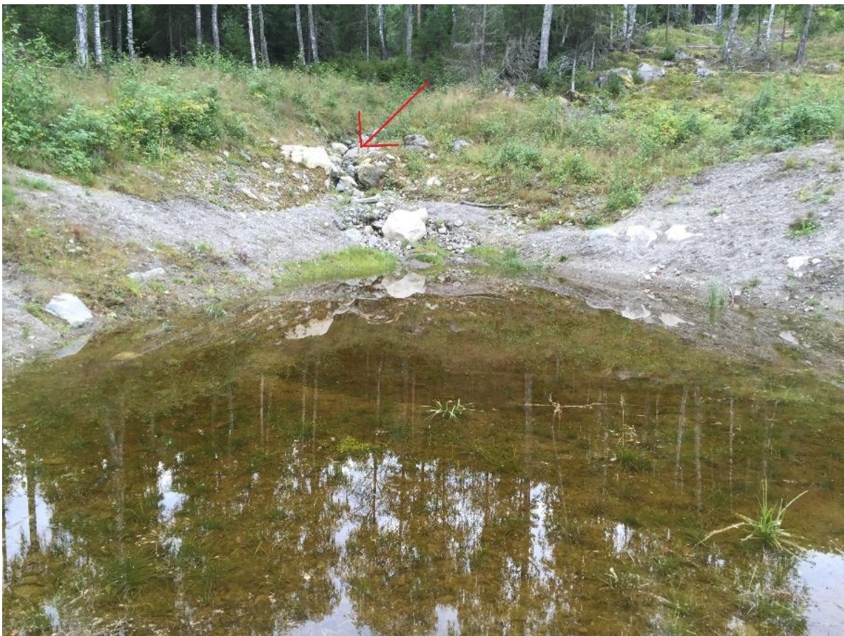
Figur 5.35 viser sedimentbassenget bak boligfeltet Bankeplassen. Den røde pilen viser hvor skredbanen gikk før bassenget ble bygget. Foto: Renate R. Johansen
