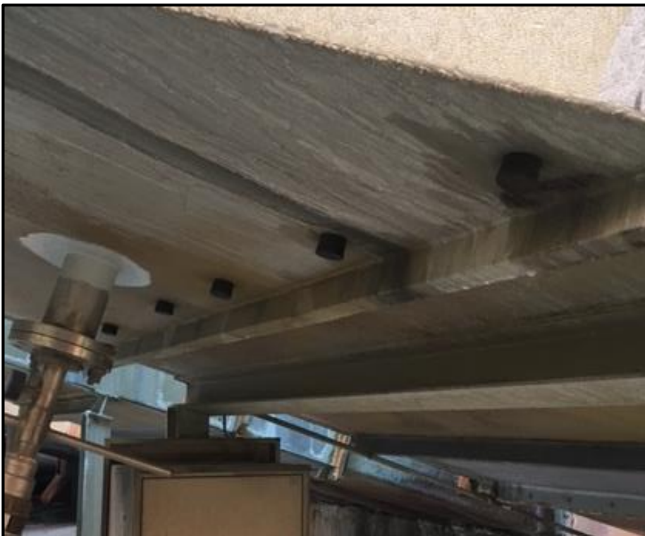
Figur 5-8: Ferdig borede hull, tettet med gummikorker
