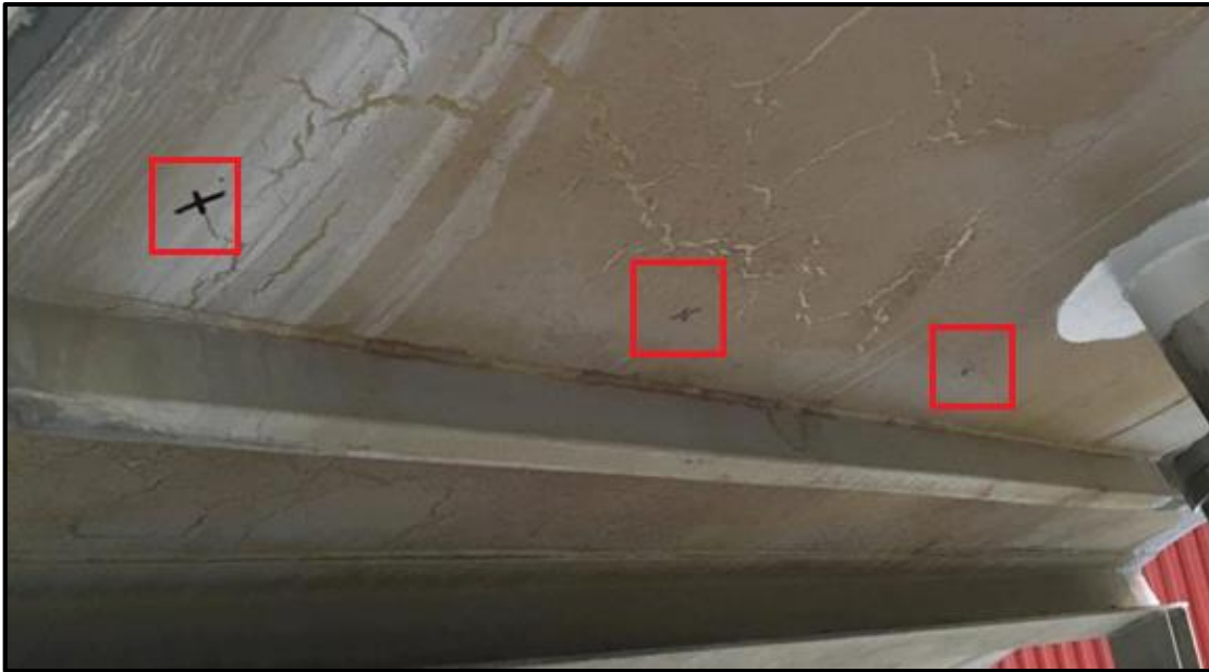
Figur 5-7: Punkter markert for boring av hull
