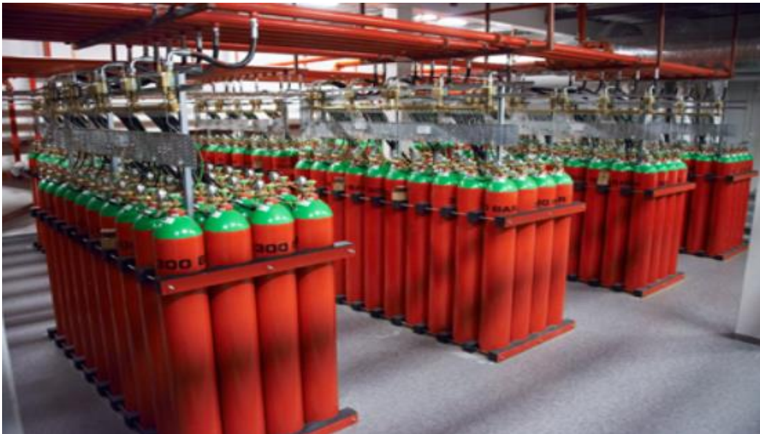
Figur 8 – Illustrerer oppbygningen av en flaskebank (Rettigheter fra Fire Eater AS)
