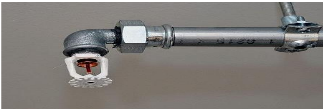
Figur 5 - Illustrasjon av et sprinklerhode montert på et rørnettverk (rettigheter fra Vårt Land).
