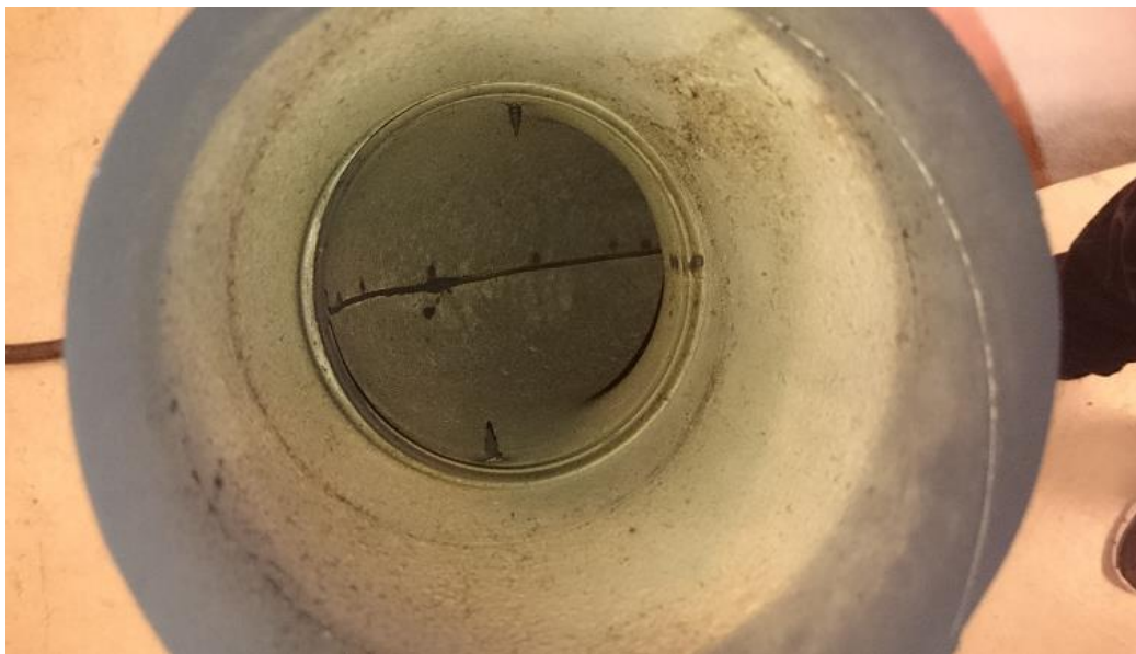
Figur A10. Innsiden av den vertikale rørdelen og 90 graders røret etter forsøket.
