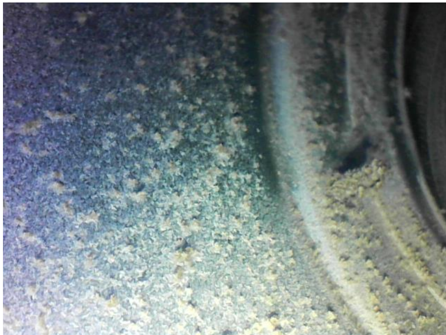
Figur 7. Nærbilde av avtrekkskanalen i leilighet nr 5.
