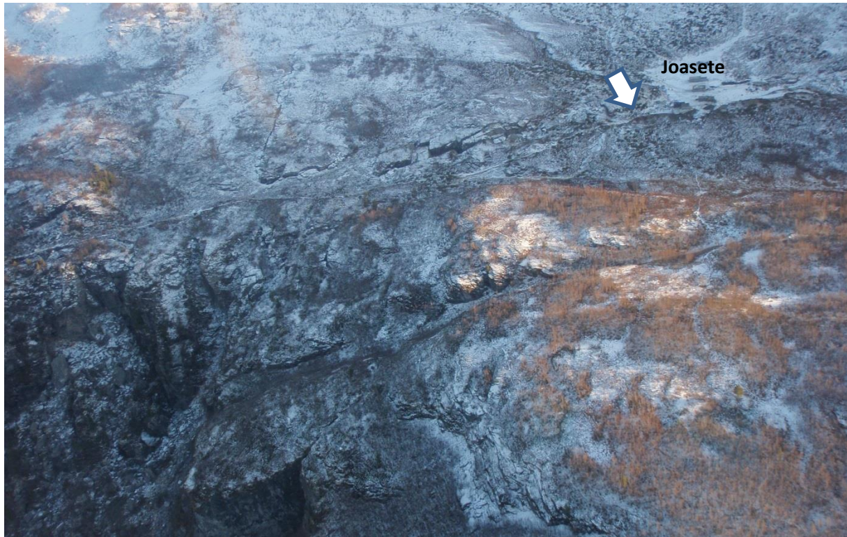
Fig.26 Fyllitten på fjellplatået er lokalt godt oppsprukket i minst tre retninger, der to ortogonale retninger dominerer. Retningene fortsetter ut mot skrenten i forkant av fjellplatået. Joasete er øverst til høyre i bildet. Pil markerer infiltrasjonsområdet langs Joasetegrovi.
