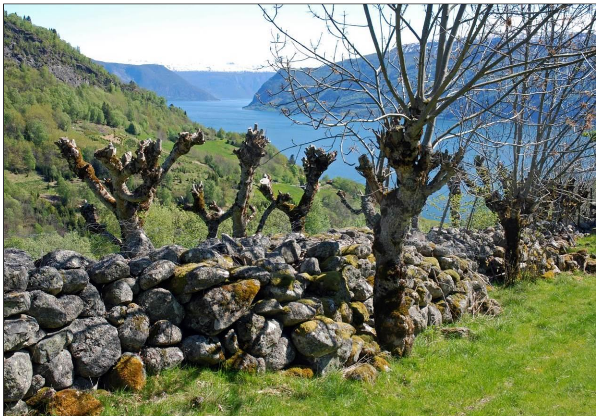
Figur 43. Rydningsstein frå slåttemarka er her lagt opp i ein kraftig steingard som også avgrensar to eigedomar og ein gamal bu- og utmarksveg. Langs muren er asketre planta, truleg på 1930-talet, både på oppsida av muren og nedsida av buvegen. Trea vert styva.
