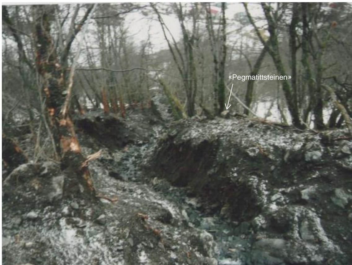
Figur 58. Oppe i skredløpet til Klinthammarfonna 28.11.2008, dagen etter skredhendinga. Ser nedover i skredløpet. Ein kjend stein av Gunnar Velle kalla «Pegmatittsteinen» er oppe på kanten til høgre, er 58 cm lang og vert brukt som målestokk. Skadane på trea er omtrent 1 ½ m opp på stammen. Medan skredkanalen er om lag 2 ½ m brei og nesten 2 m høg. Foto: Harald og Gunnar Velle.
