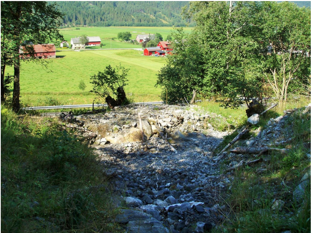
Figur 60. Er ved Lokalitet 16, der det er bygt opp ein liten voll i dagens skredløp rett over Fv. 60. Vollen er 50 – 60 cm høg og 2 m brei. Målestokken på biletet er 1 m lang. Fotografen står med ryggen til fjellsida og ser mot Fv. 60, der vollen er midt på biletet. Vatnet blir leia til høgre på biletet, altså i retning nord.
