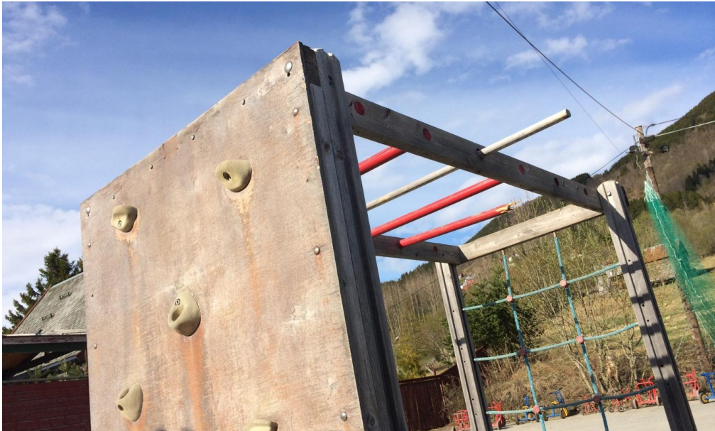
Figur 25 Klatrestativet er gammelt og mangler flere klatrehåndtak
