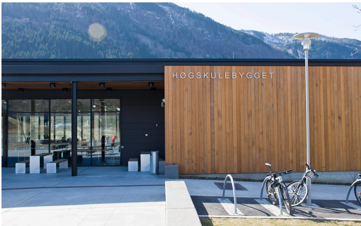
Figur 15 Inngang 5. Etasje. Utendørs lysmast og kantine sett fra østvendt langsida (Foto: Espen Mikkelsen)
