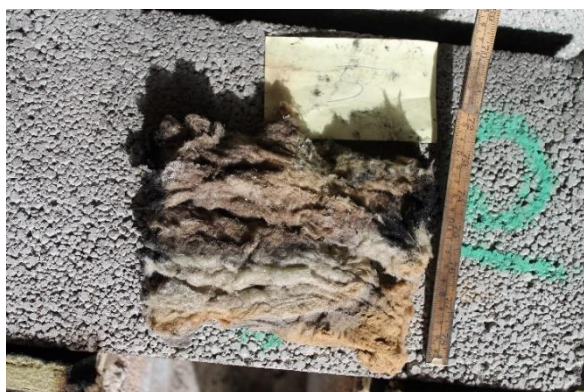
Bilde 10: Fuge 5 etter forsøket, gjennombrenning og røyk kom ut fra venstre side
