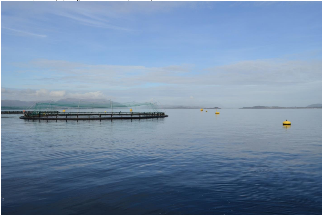
Figure 3 - Bilde av plastanlegg.
