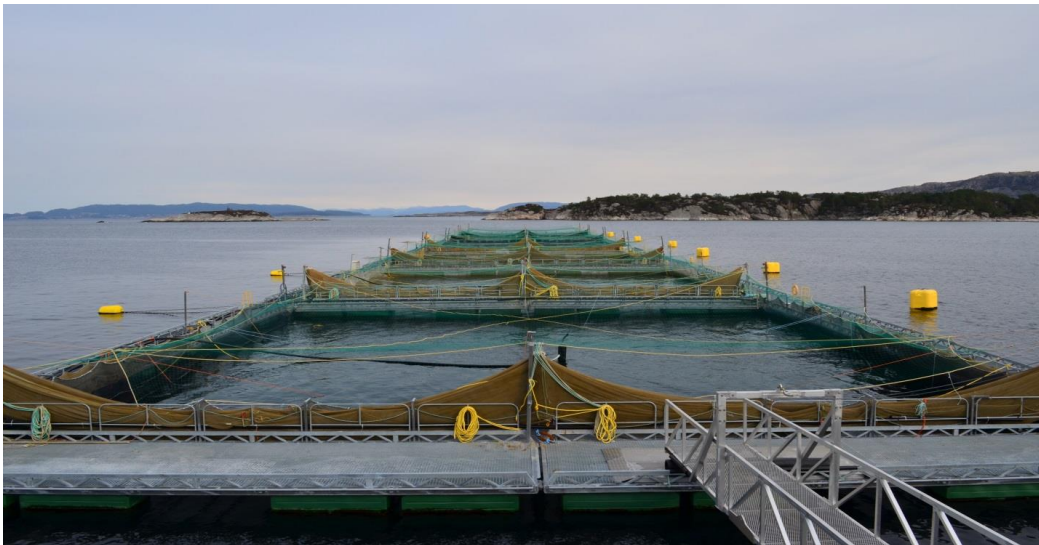
Figure 4 - Bilde av stålanlegg.
