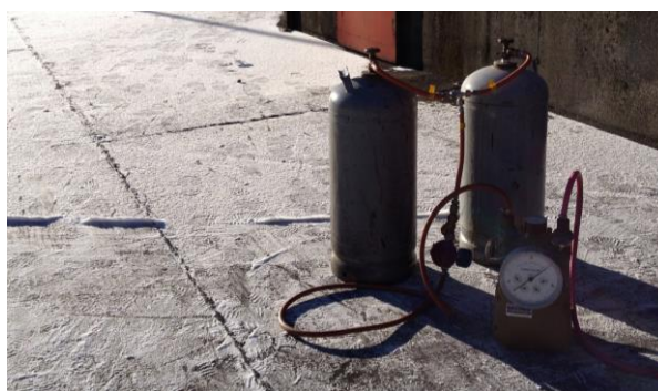
Figur 10 - Propanflaske med slange og gassmåler
