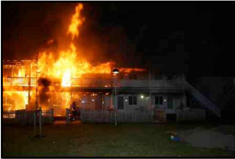
Figur 3.7: Bilde fra Nannestad-brannen viser brannspredning under svalgangstaket i andre etasje. (DiBK, 2009)
