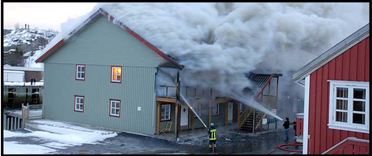
Figur 3.6: Bilde fra Kabelvåg-brannen.
