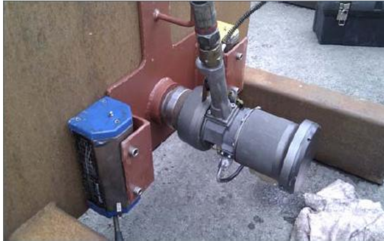
Figur 11 - R1004 verktøyet brukt med magnetklemme til reparasjon i "splash-sonen" på en FPSO (7)
