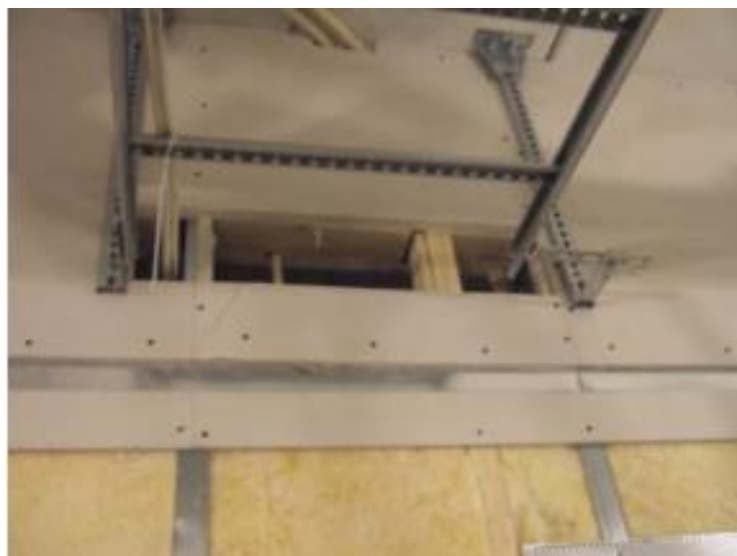
FIGUR 33: EKSEMPEL PÅ KOMBINERTE HORISONTALE OG VERTIKALE GJENNOMFØRINGER
