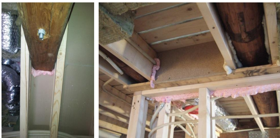
FIGUR 42: EKSEMPEL PÅ BRUK AV BRANNSKUM
