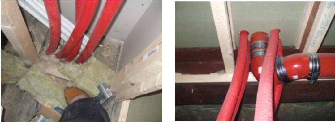
FIGUR 38: EKSEMPEL PÅ GJENNOMFØRING AV ISOLERTE VANNRØR
