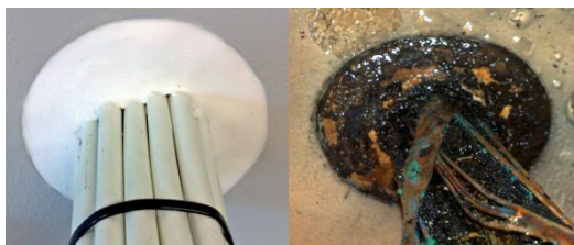
FIGUR 23: EKSEMPEL FRA TEST AV AKRYL FUGEMASSE
