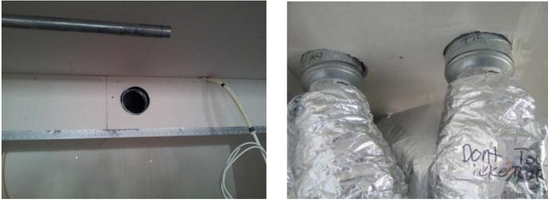
FIGUR 40: EKSEMPEL PÅ FOR TRANGE GJENNOMFØRINGER
