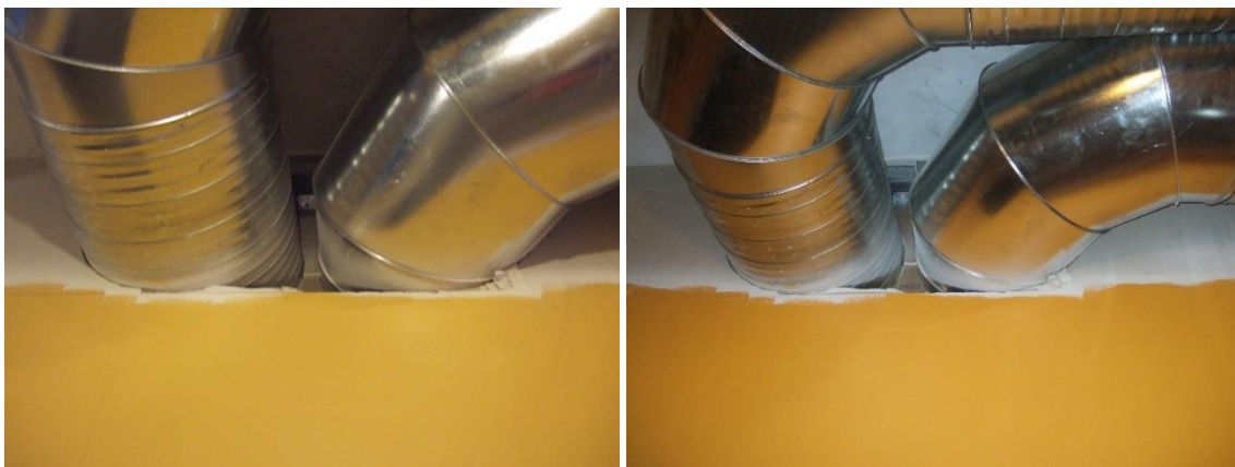
FIGUR 27: EKSEMPEL PÅ UTFØRT UTSPARING FOR GJENNOMFØRING AV VENTILASJONSKANAL
