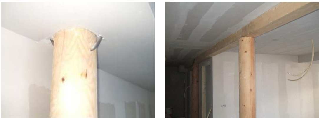
FIGUR 41: BÆRESØYLE GJENNOM HIMLING
