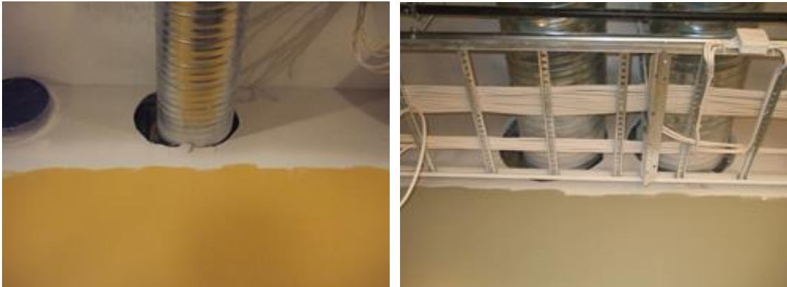
FIGUR 29: EKSEMPEL PÅ EKSENTRISK PLASSERING AV KANALER I UTSPARING
