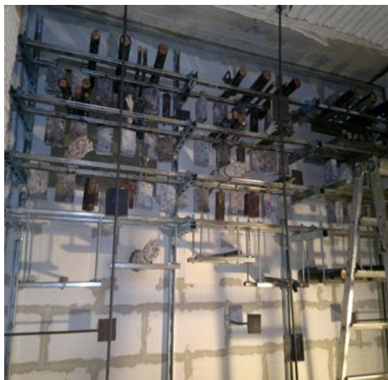
FIGUR 4: KABLER MONTERT I EN SKILLEKONSTRUKSJON SOM SKAL TESTES HORIZONTALT
