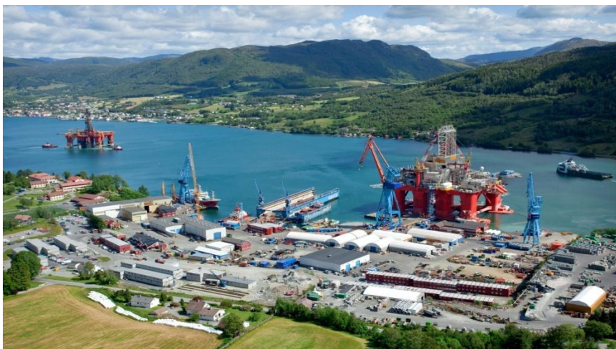
Figur 3 Oversikt-bilde av Westcon Yard i Ølensvåg.
