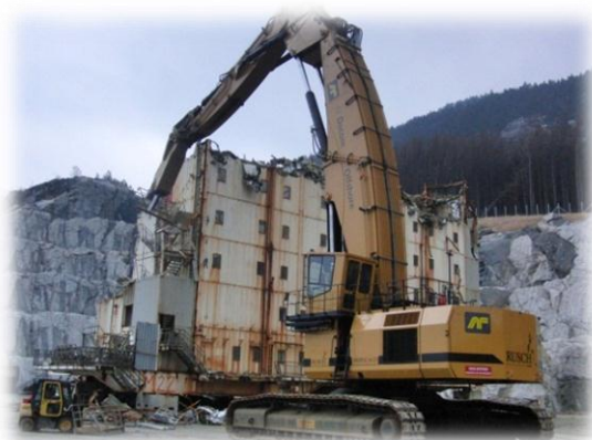
Figur 3 - "Storeulv" under riving av boligmodul
