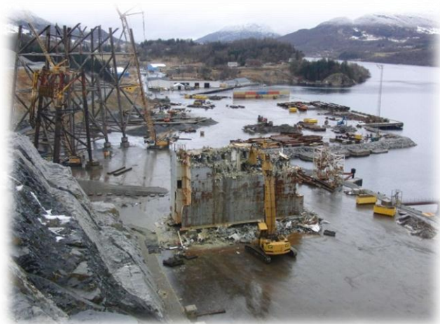
Figur 4 - Bilde over anleggsområdet
