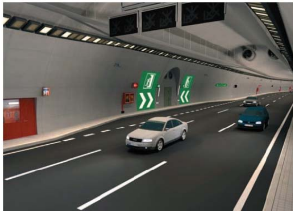
Figur 56: En tydeligere måte å skilte nødutganger på
